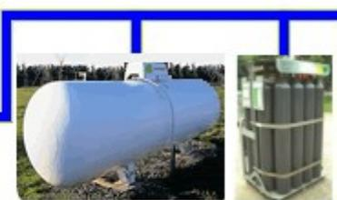
Stockage de l'hydrogène (H<sub>2</sub>) en citerne et ou en bouteilles à une pression ne dépassant pas 50 bars
